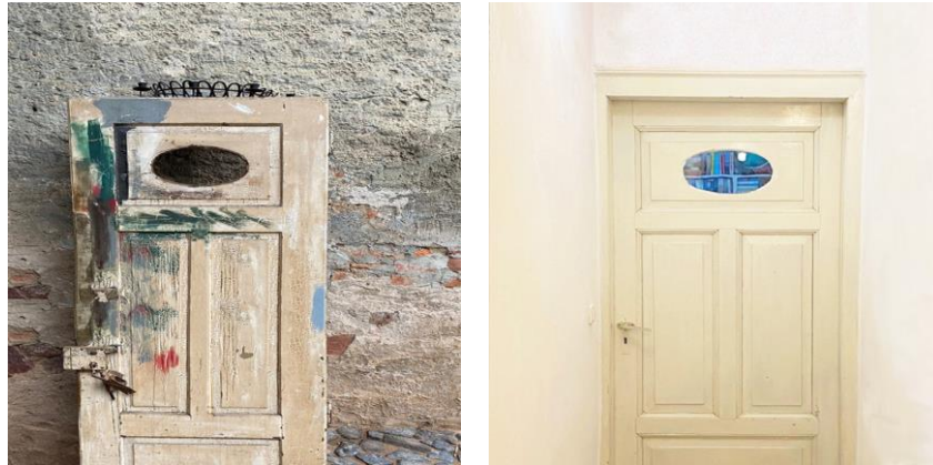
Abb. 7: Alte Außentür wurde in Otzberg restauriert und ist mit einem frischen Anstrich ein Blickfang als neue Zimmertür (eigene Fotos)
